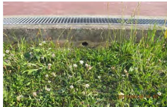
(排水溝の様子)
